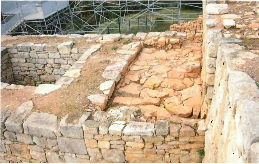
Empedrat de lloses sobre el tapiat de la poterna, al sector B4 de la segona muralla ibèrica, a l'esquerra de la torre 1. Un paviment semblant degué coronar la part alta de tota aquesta fortificació.
