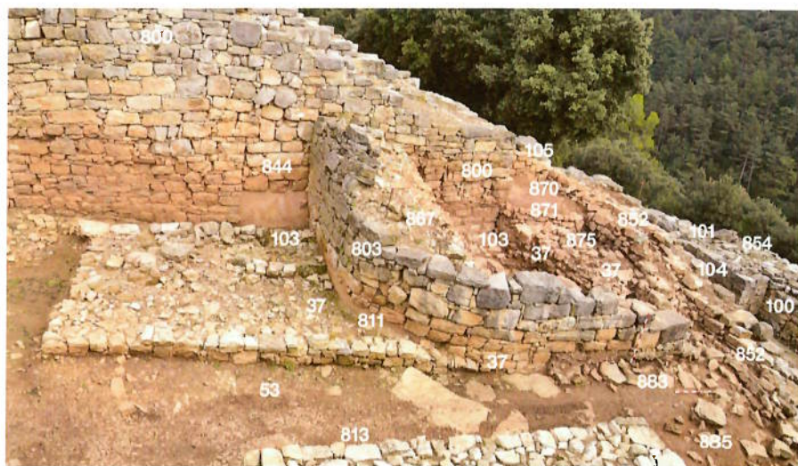
Ruïnes de la primera muralla ibèrica (37, 103) i la torre 6 (803), ja excavada, que s'hi superposa, vistes des de ponent. Al fons la segona muralla (800, 844). Tot plegat amb la nomenclatura de les unitats estratigràfiques diferenciades.
