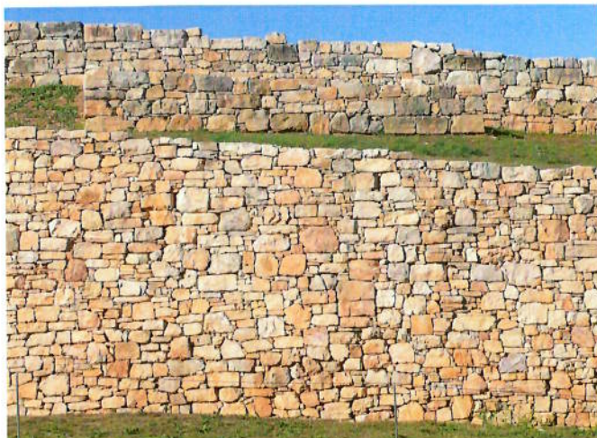
Detall dels paraments de l'escarpa del fossat, en primer terme, la torre 2, sobre la berma, i la segona muralla ibèrica, al capdamunt, després de la seva consolidació.
