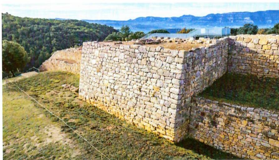
Detall de la segona muralla ibèrica o muralla principal des del sud. En primer terme, la torre 1 flanquejada, a la seva dreta, pel tram de mur dotat de casamates i reforçat amb un pany extern i, a l'esquerra, per l'inici del fossat amb l'escarpa fortificada.
