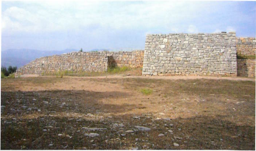
Detall de la segona muralla ibèrica des del sud. La torre 1 i, a la seva esquerra, poterna tapiada i mur reforçat amb un pany extern. A la dreta, inici del fossat amb l'escarpa fortificada.
