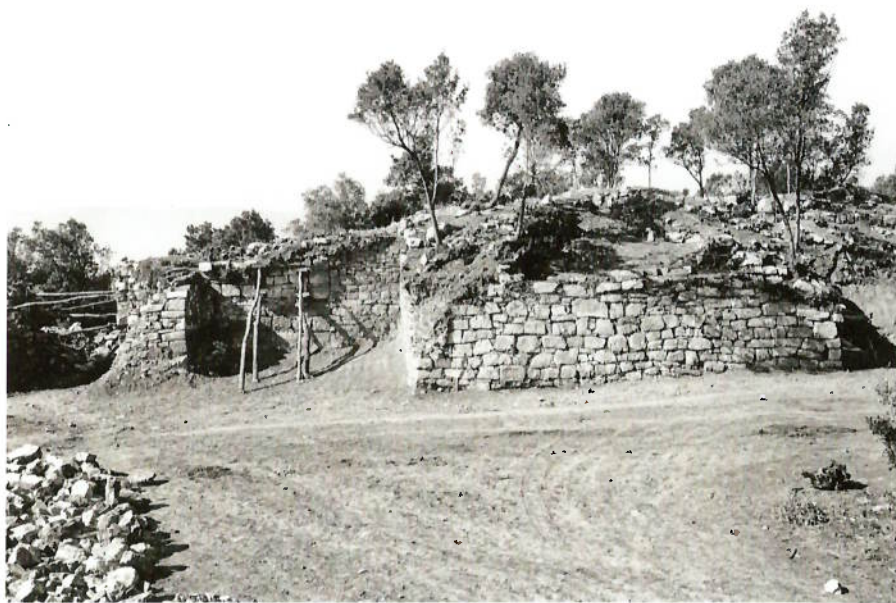
Consolidació d'urgència d'algunes estructures de la segona muralla ibèrica, al poc temps de descobrir-se. A l'esquerra, estrobat amb troncs del forat on va quedar encastada la màquina que, en arrencar-ne pedres, va palesar la presència del monument.
