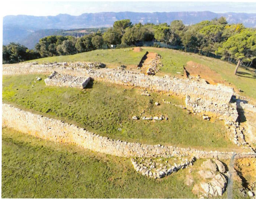
Tram final del fossat pel costat nord. A la part baixa, a la dreta, aflora la roca natural. Abans, hi ha les ruïnes d'una bestorre o torre semicircular (núm. 5) adossada a l'escarpa. Al capdamunt, sobre la berma, hi ha les ruïnes de la torre 3, a la dreta, i de la torre 2 o talaia, a l'esquerra.
